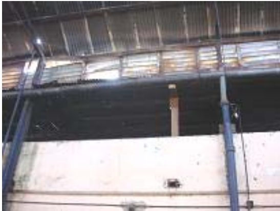
Se aprecia longitudinalmente la falta de cubriera en el techo.
