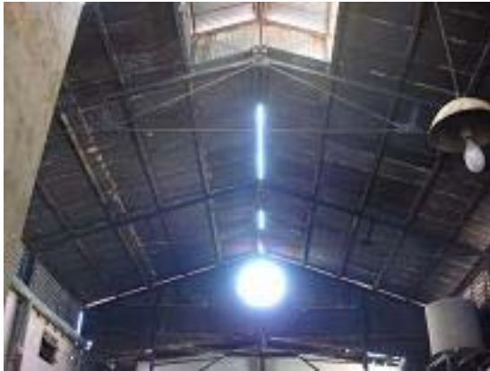
Se aprecia longitudinalmente la falta de cubriera en el techo.
